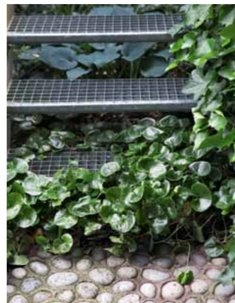
Onder aan de trap naar het dakterras is een tableau gemaakt van strandkeitjes (pebbles). De ondergrond is een 10 cm dik bed van geel zand met een bovenlaag van 5-10 cm cement, waarin de keitjes met de hand zijn ingelegd. Hetzelfde tableau is nog een keer herhaald bij de tuinpoort aan het eind van de gang. Verder is er een rand met pebbles rond het terras gelegd. Omdat de traptreden bestaan uit roosters is er onder de trap voldoende licht voor diverse bladplanten, zoals Asarum , Hosta en Carex morrowii 'Variegata'.
